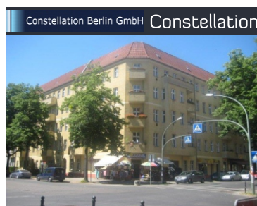
Constellation Berlin GmbH Constellation 1 Gebäude 110 Räume 124 Heizkörper
