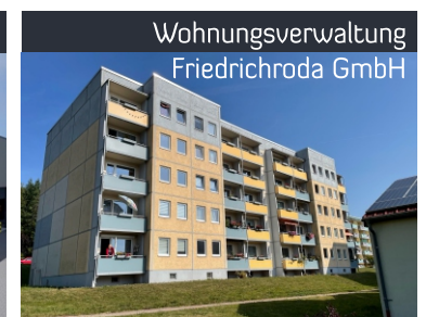
Wohnungsverwaltung Friedrichroda GmbH 1 Gebäude 50 Räume 114 Heizkörper
