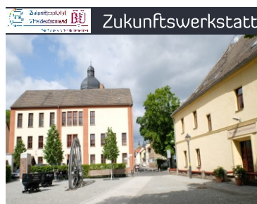
Zukunftswerkstatt 2 Gebäude 51 Räume 106 Heizkörper
