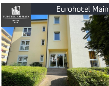
Eurohotel am Main 1 Gebäude 162 Räume 178 Heizkörper
