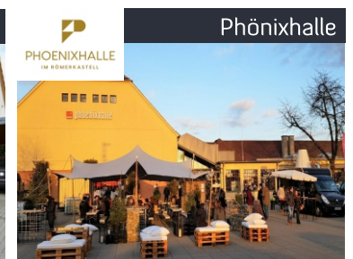
PHOENIXHALLE 1 Gebäude 1 Räume 85 Heizkörper
